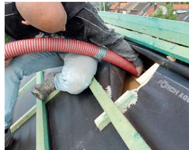
▲ Zejména u střech s již vybudovaným podkrovím je metoda foukání výhodou. Střecha se rychle zakryje pojistnou difuzní hydroizolační fólií a až následně se postupně zatepluje z vnější strany. Dům je přitom již dobře chráněn proti dešti a nehrází žádné škody. Metoda foukání umožňuje flexibilní dodatečné zesílení již existující izolační vrstvy. Izolace přilne ke všem detailům původní i nové části konstrukce; objekt se výrazně zhodnotí a výdaje za energie se značně sníží.
