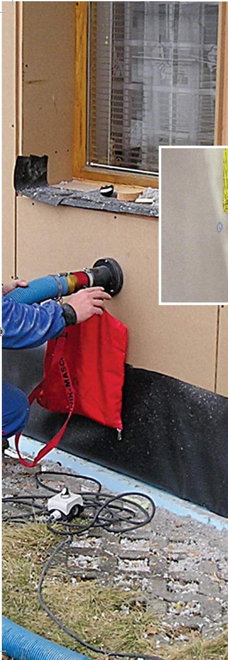
▼ **Climatizer Plus®** je možné také plnit do prefabrikovaných konstrukcí přímo při jejich výrobě v továrně. Při tomto způsobu aplikace je však nutné užívat objemovou hmotnost 60–70 kg/m<sup>3</sup>, aby nedošlo v průběhu transportu k slehnutí, a tím ke vzniku tepelného mostu. Nevýhoda poněkud vyšší spotřeby materiálu je kompenzována komfortem a vyšší produktivitou tovární práce.
