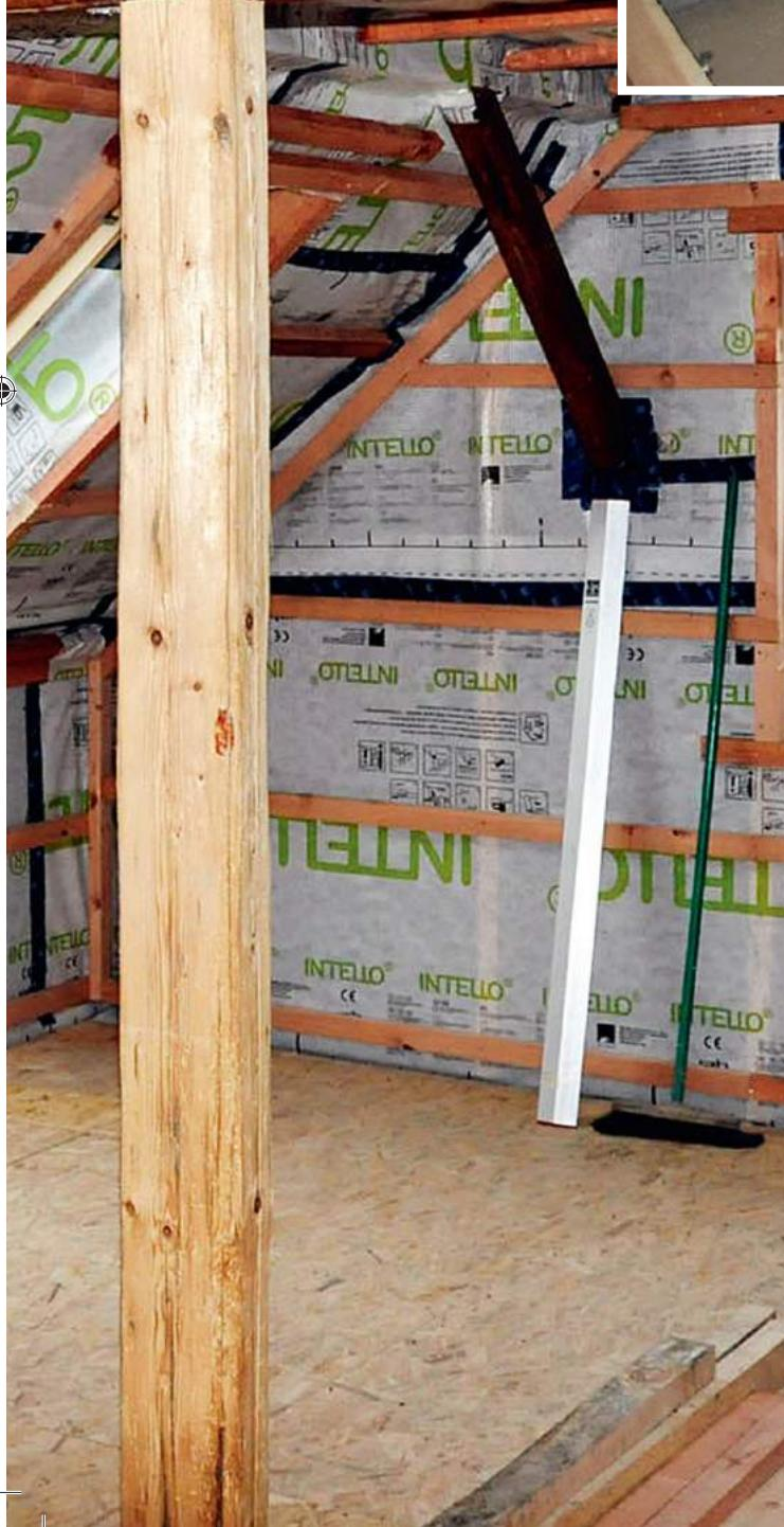
▲ V případě střech bez odvětrání nebo s krytinou na plném bednění, jako je například bitumenový šindel, je možné izolaci foukat i přímo pod bednění bez odvětrávací mezery. Musí však být ze strany interiéru chráněna správně provedenou parotěsnou nebo parobrzdou vrstvou, ověřenou výpočtem.
