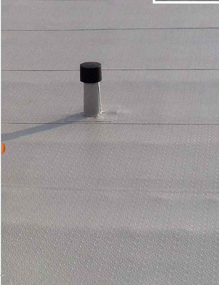
▲ U průlezných střech se využívá obvykle ke vstupu větších otvorů. Po dokončení izolačních prací se tyto otvory využívají jako větrací šachty pro aktivní odvětrávací hlavice. Ty je vhodné umístit na zvýšenou nástavbu s větší šírkou, aby se tak snížila rychlosť proudění vzduchu při zachování jeho maximálního objemu. Nástavba také lépe funguje při vysoké sněhové pokrývce střechy.
