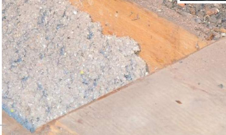
◀ Pro otevření konstrukce starého trámového stropu postačí pouze odtržení jednoho záklopového prkna. Dutinu stropu lze následně vyfoukat izolačním materiélem až do vzdálenosti 4 m na každou stranu. Bez větších nároků na stavební úpravy je tak možné izolovat původní strop a výrazně tím snížit výdaje za vytápění.
