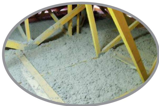
▲ V případě, že půdní prostor nebude již pochozí, lze izolační materiál aplikovat přímo na původní konstrukci, foukání na volno je jeden z nejfektivnějších způsobů zateplení. Tloušťka izolačního materiálu je libovolná a nejčastěji se pohybuje v rozmezí 25–40 cm. Pro účel přístupu k technologickým zařízením je vhodné v půdním prostoru předem zhotovit revizní lávku.
